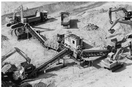
図 1 万能土質改良機システムの全景
