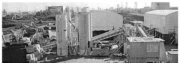
写真-1 ツイスター工法施工状況 (VOC 汚染土壌の無害化処理工事)
