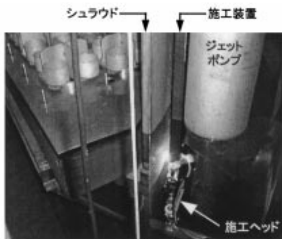
図4 炉心シュラウドの遠隔施工試験
